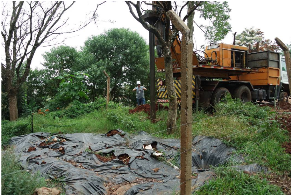
Figura 1. Depósito irregular de resíduos e trabalhos de perfuração de solo.
