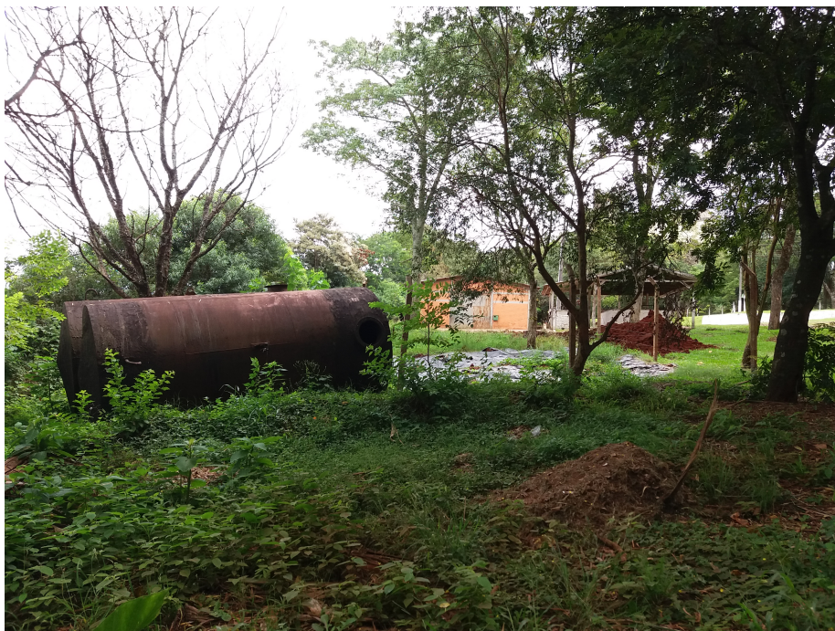
Figura 4. Tanques de emulsão asfáltica desativados que devem ser removidos.
