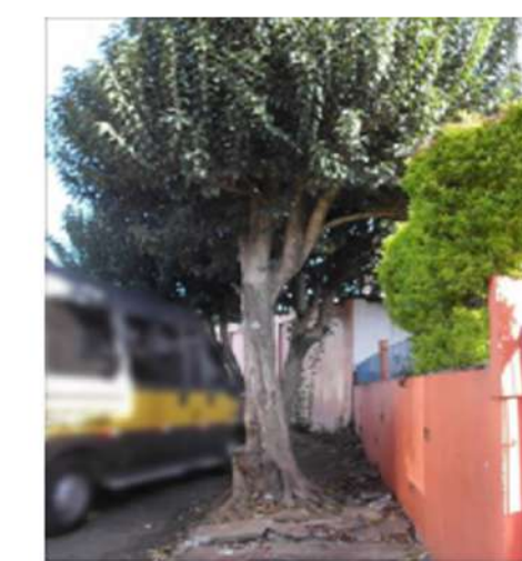
INTERRUPÇÃO DO PASSEIO/ RAÍZES EXPOSTAS
